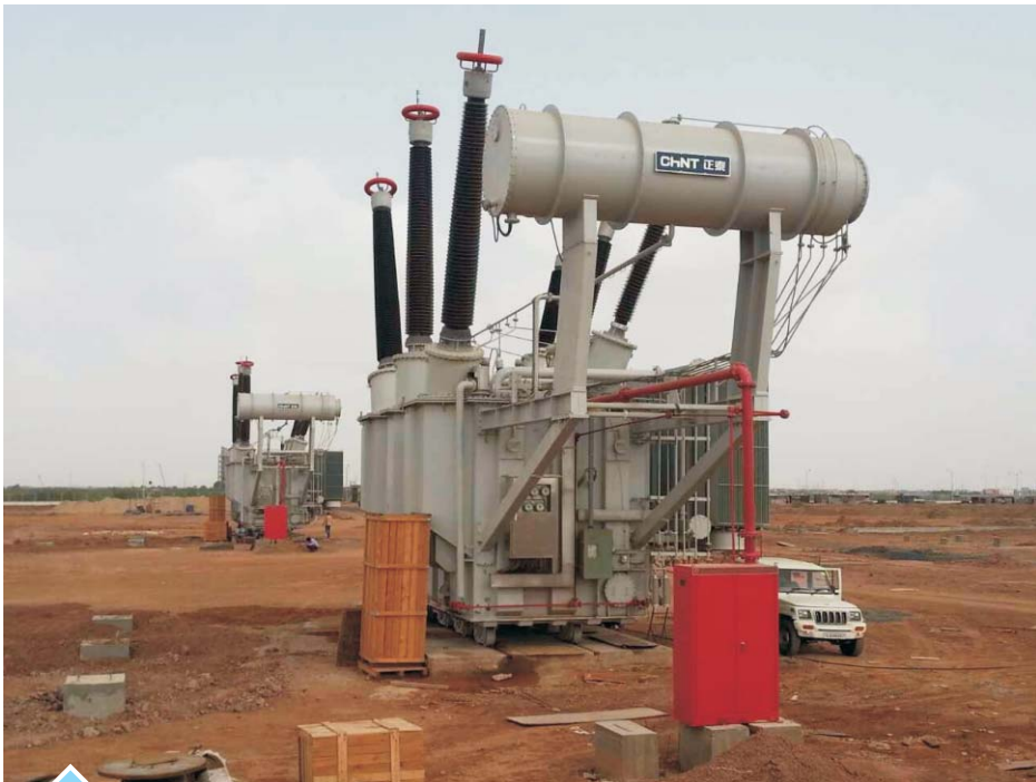
印度 GETCO项目 OSFPS-315MVA 400kV
