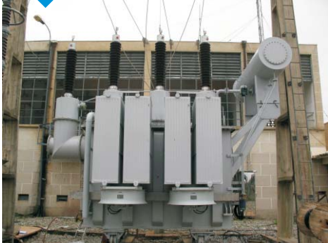
刚果 布昂扎水电站 SFSQ-16MVA 110kV
