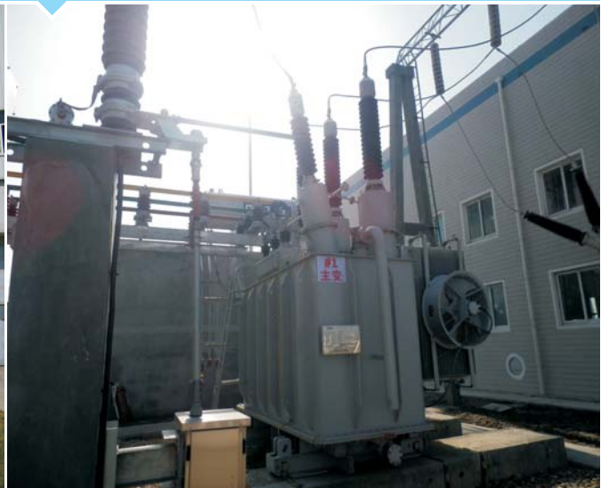
江苏 龙源启东东元风电场 SZ11-50MVA 110kV
