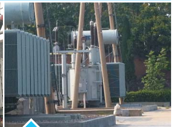
国网湖北 随州变SFSZ11-180MVA 220kV
