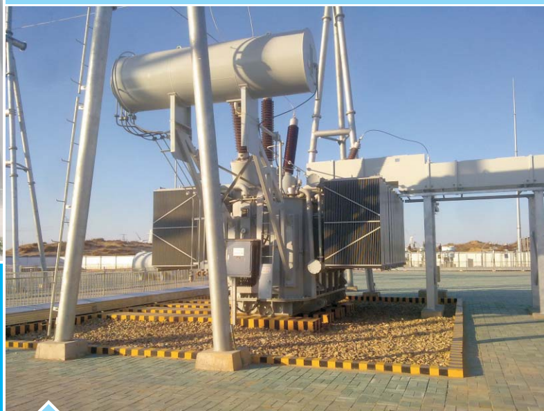
内蒙 华能通辽珠日河风电场工程 SZ11-100MVA 220kV
