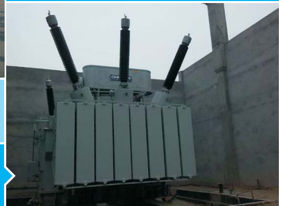
黑龙江 建龙钢铁有限公司轧钢变 SZ11-50MVA 220kV
