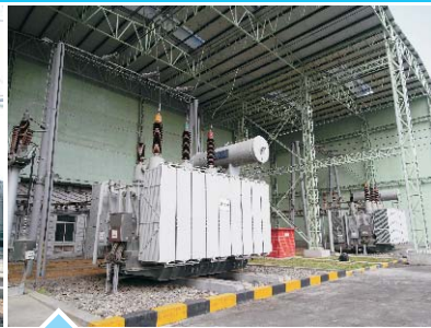
国网四川 成都苏坡变SZ11-63MVA 110kV
