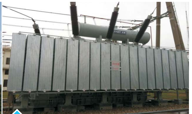
国网福建 井山变 SSZ11-180MVA 220kV
