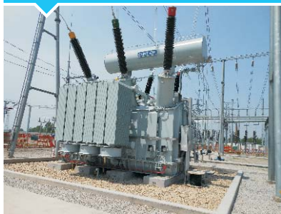
南网云南 抚仙变电站SFSZ11-H-240MVA 220kV(GYW)
