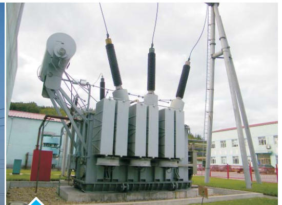
黑龙江 建龙钢铁有限公司轧钢变 SZ11-50MVA 220kV
