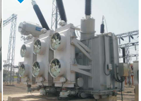
朝鲜 龙光贸易项目 OSFPS-160MVA 210kV
