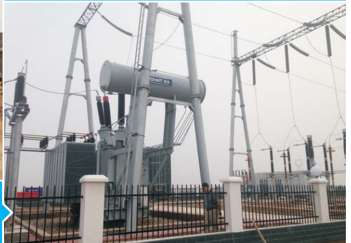
江苏 龙源启东东元风电场 SZ11-50MVA 110kV
