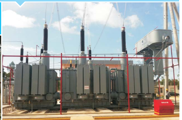
南网云南 抚仙变电站SFSZ11-H-240MVA 220kV(GYW)
