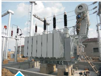
国网湖南 德山变SSZ11-K-180MVA 220kV
