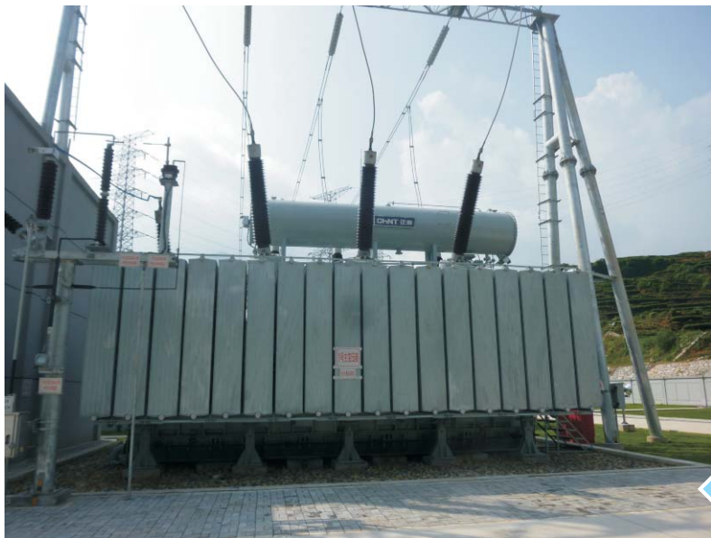
国网福建 井山变 SSZ11-180MVA 220kV
