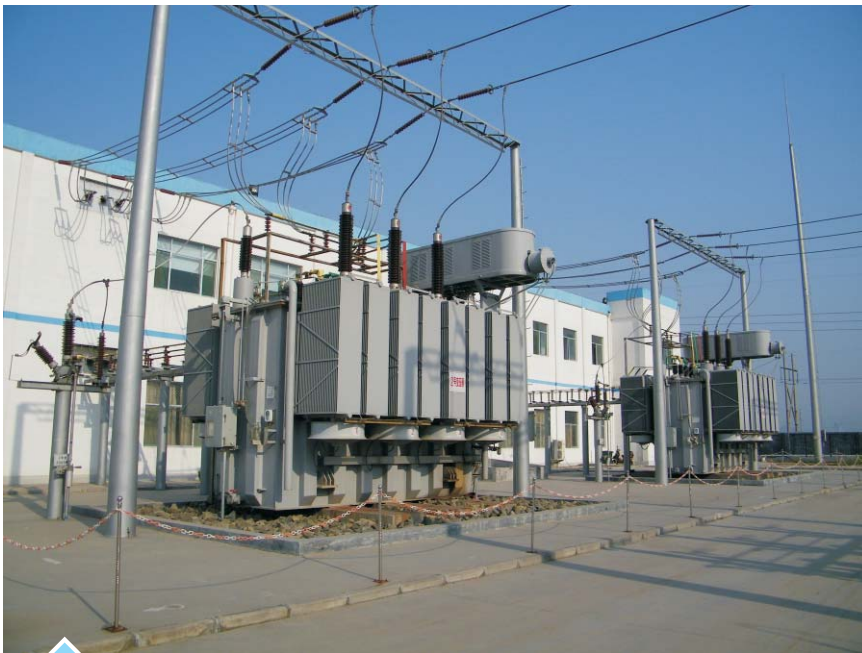
山东 西王集团有限公司110kV变电站 SFSZ11-100MVA 110kV
