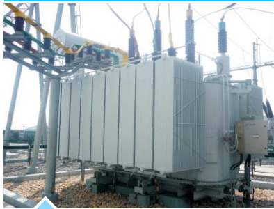
国网江苏 大衙变SSZ-80MVA 110kV
