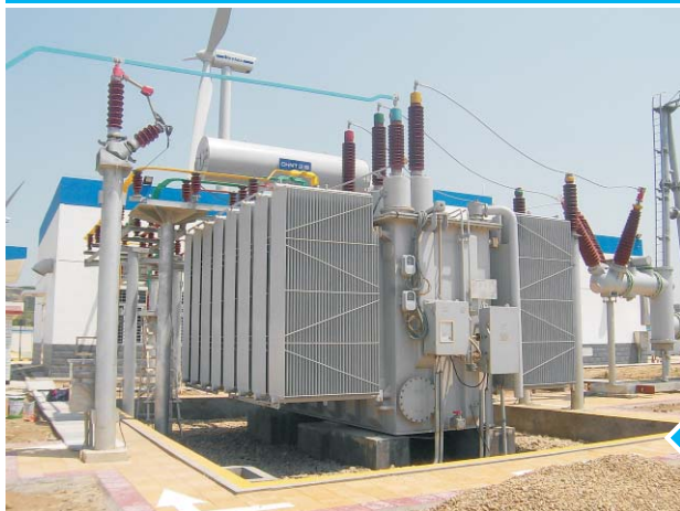
内蒙 华能通辽珠日河风电场工程 SZ11-100MVA 220kV
