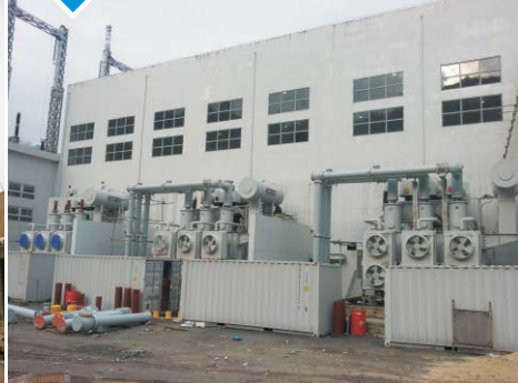
柬埔寨 达岱河水电站 SFP-100MVA 230kV
